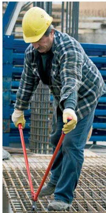
Zvláštní tvar hlavy pákových kleští na pletivo 71 82 950 umožňuje řezání ploché konstrukční oceli
