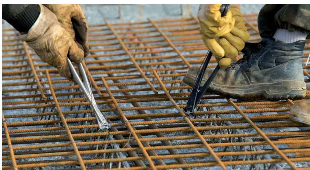
Armování je ruční práce – všude na světě, v nejrůznějších budovách. Armovací kleště KNIPEX nabízí stavařům výkonné, ergonomické řešení pro jejich výrobu.
